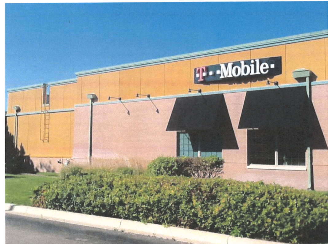
EXISTING TENANT SIDE
