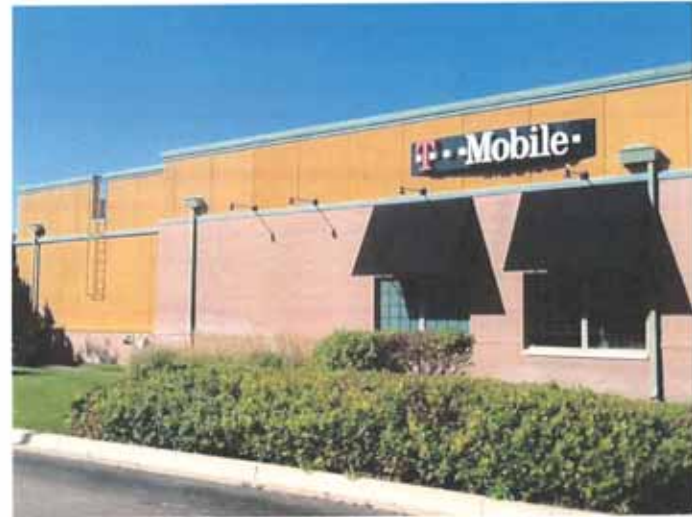
EXISTING TENANT SIDE
