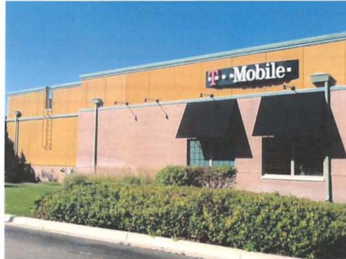
EXISTING TENANT SIDE
